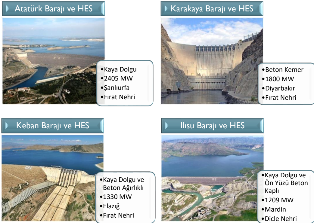
Şekil 5-2 Türkiye’nin en büyük dört hidroelektrik santralleri 13
